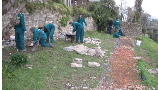
Studenti che realizzano un muro a secco
